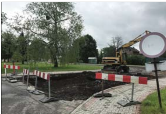
W centrum Gm. Bobrowniki prace będą polegać na zagospodarowaniu i uporządkowaniu ruchu kołowego oraz pieszego.
